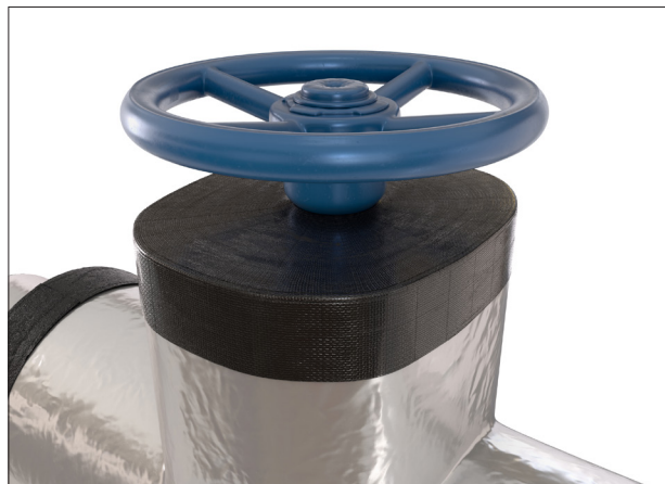
Рисунок 57: Нанесение пароизоляции на оконечность изоляции шпинделя
