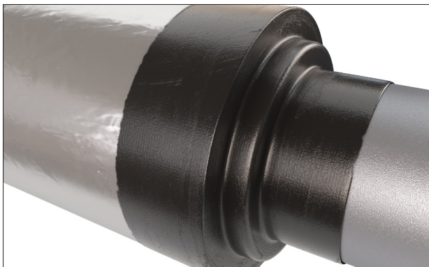
Рисунок 13: Нанесение пароизоляции на оконечность изоляции
