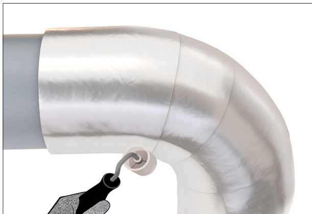
Рисунок 69: Фиксация нахлестов валиком
