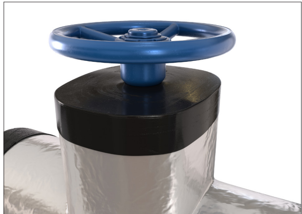
Рисунок 55: Нанесение пароизоляции на шпindelь арматуры
