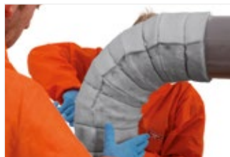
Рисунок 37. Соедините все клиновидные сегменты и убедитесь в отсутствии зазоров на стыках, а затем затяните проволоку.
