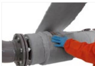
Рисунок 32. Намотайте до толщины, равной толщине ArmaGel HT на трубе.
