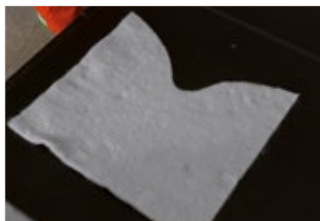
Рисунок 52. Отрежьте материал для наклонного ответвления.
