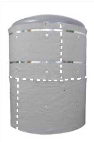
Рисунок 60. Начинайте изолировать с линии сварки днища ёмкости. Зафиксируйте лист изоляции ArmaGel HT с помощью булавок, чередуя соединения в шахматном порядке, а затем привяжите каждый слой к ёмкости полосой.
