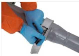
Рисунок 42. Измерьте обе длины окружности по сварному шву.
