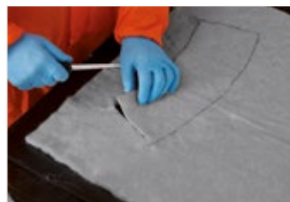
Рисунок 43. Вырежьте закругленную полосу.
