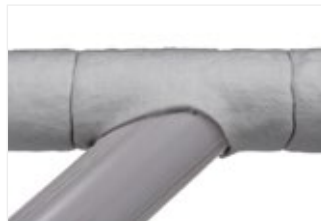
Рисунок 51. Обмотайте вокруг трубы и зафиксируйте проволокой.
