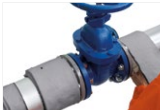
Рисунок 54. Необходимо наматывать полосы ArmaGel HT вокруг трубы, пока изоляция не станет больше наружного диаметра фланца.
