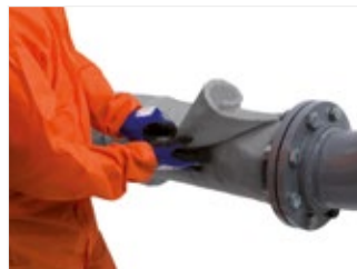
Рисунок 25. Наматывайте изоляцию вокруг трубы до получения необходимого числа слоев. В конце оборачивания продольный край должен находиться на одной линии или перекрывать исходную точку внутреннего слоя.
