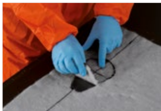
Рисунок 50. Сделайте вырез для наклонного ответвления.
