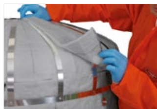
Рисунок 62. Соединения в последующих слоях должны располагаться в шахматном порядке.
