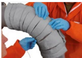
Рисунок 40. Соедините все клиновидные сегменты и убедитесь в отсутствии зазоров на стыках или пустот.
