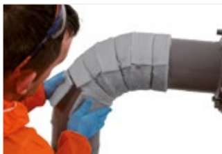
Рисунок 36. Закрепите клиновидные сегменты проволокой, чтобы их можно было двигать во время окончательной регулировки.
