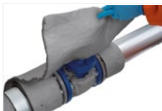
Рисунок 56. Намотка ArmaGel HT вокруг фланцев.
