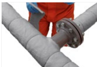
Рисунок 48. Установите часть для ответвления.
