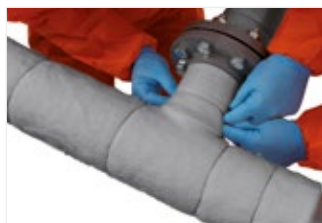
Рисунок 49. Зафиксируйте проволокой на месте.
